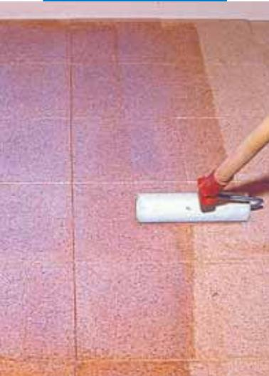
Preparazione del supporto: applicazione di Primer G su pavimentazione in marmette prima della stesura di Pianodur R
